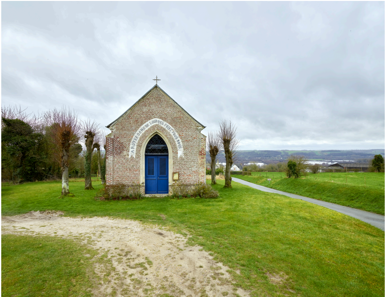
Vue de la chapelle, depuis le nord.
