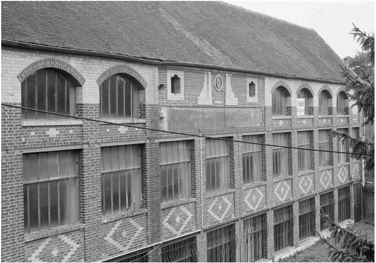
Atelier de fabrication, façade est : vue vers le nord.
