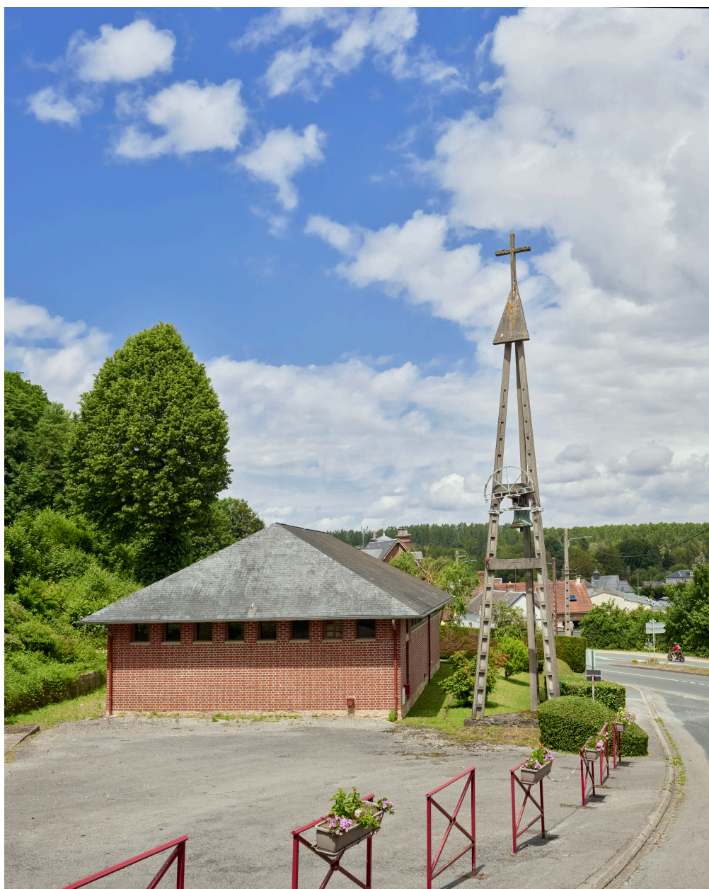
Vue de l'église, depuis le sud.
