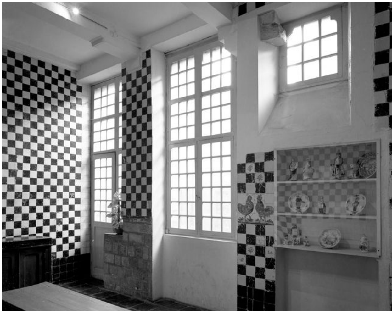
Bâtiment de la communauté religieuse, rez-de-chaussée, ancienne arrière-cuisine, élévation intérieure du mur donnant sur la cour.
