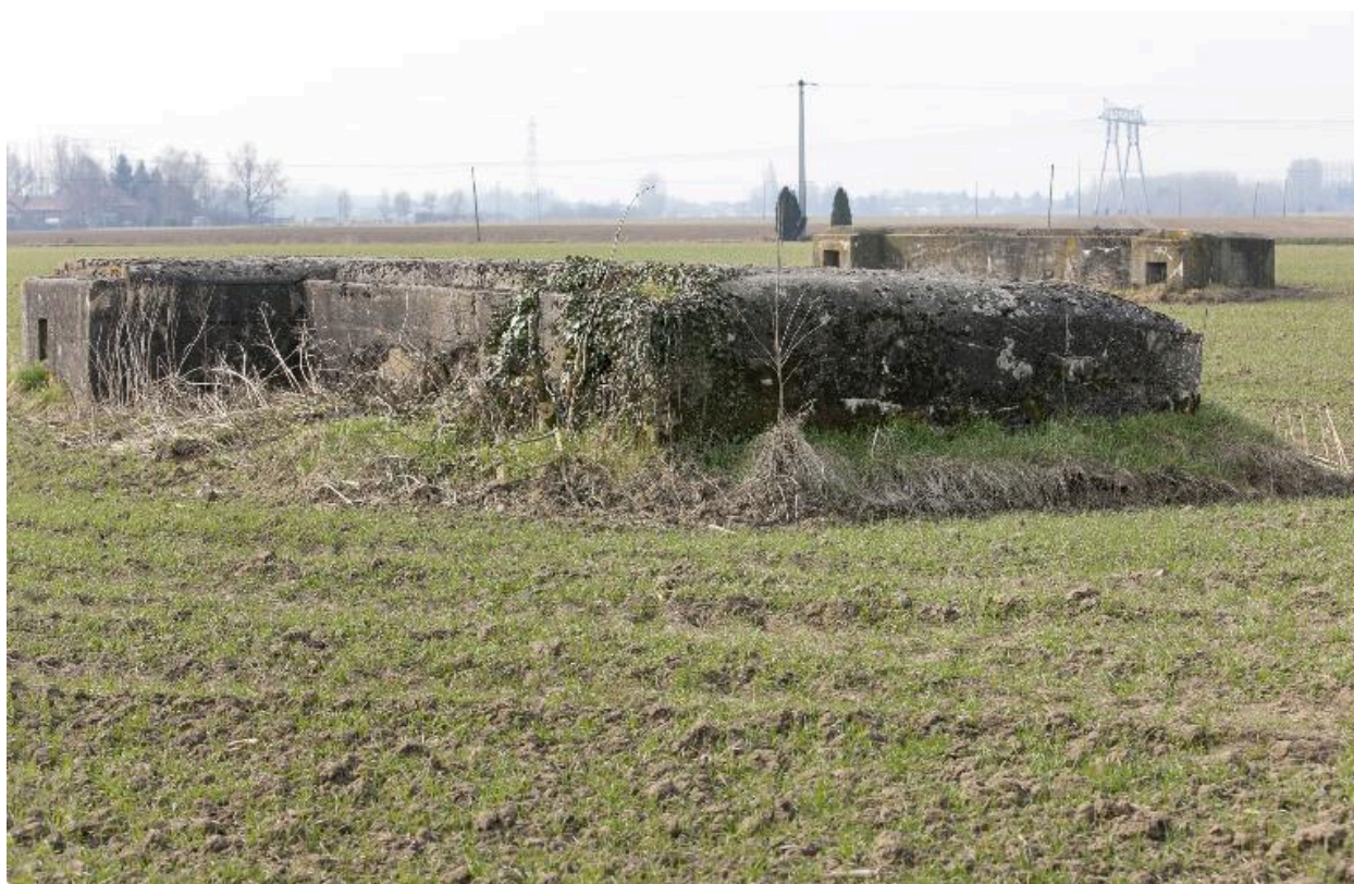
Ouvrage en L
