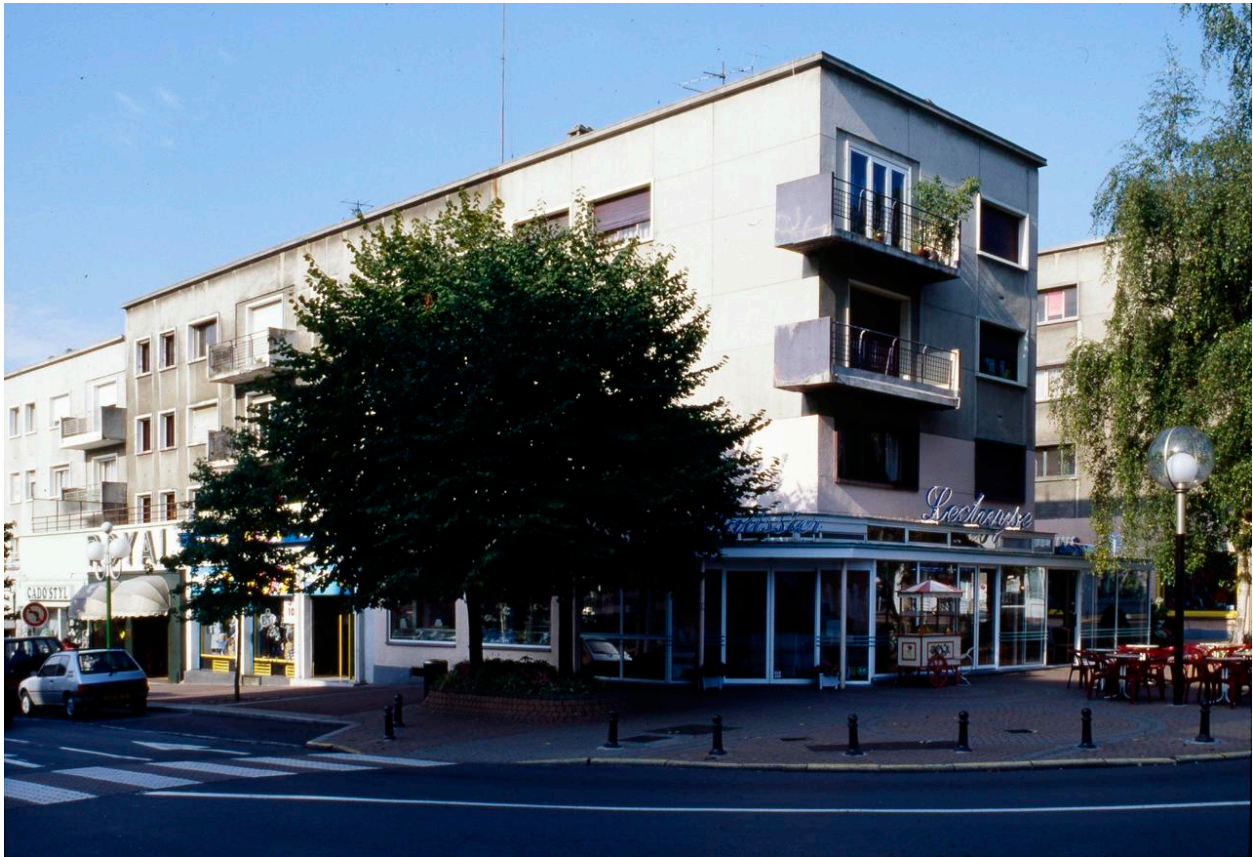
Vue de l'immeuble prise depuis le nord.
