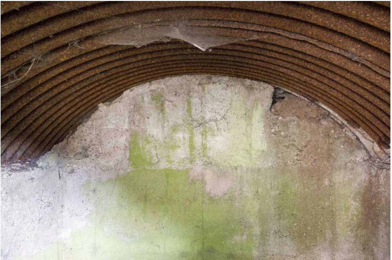
Vue intérieure de la casemate à munitions, probablement celle de la position II sur les document britanniques
