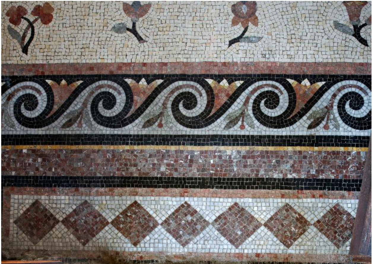
Pavage du vestibule, détail de la frise.
