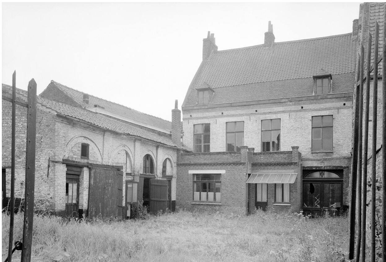
Façades sur cour de plusieurs bâtiments (logement et remises) autrefois dans l'enceinte de l'usine Annebicque.
