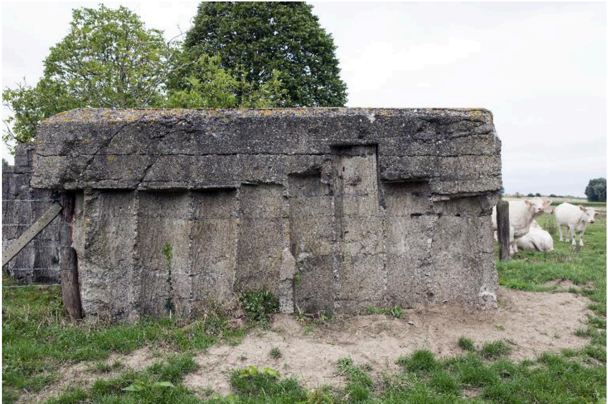
Partie sud de l'édifice, vers le nord
