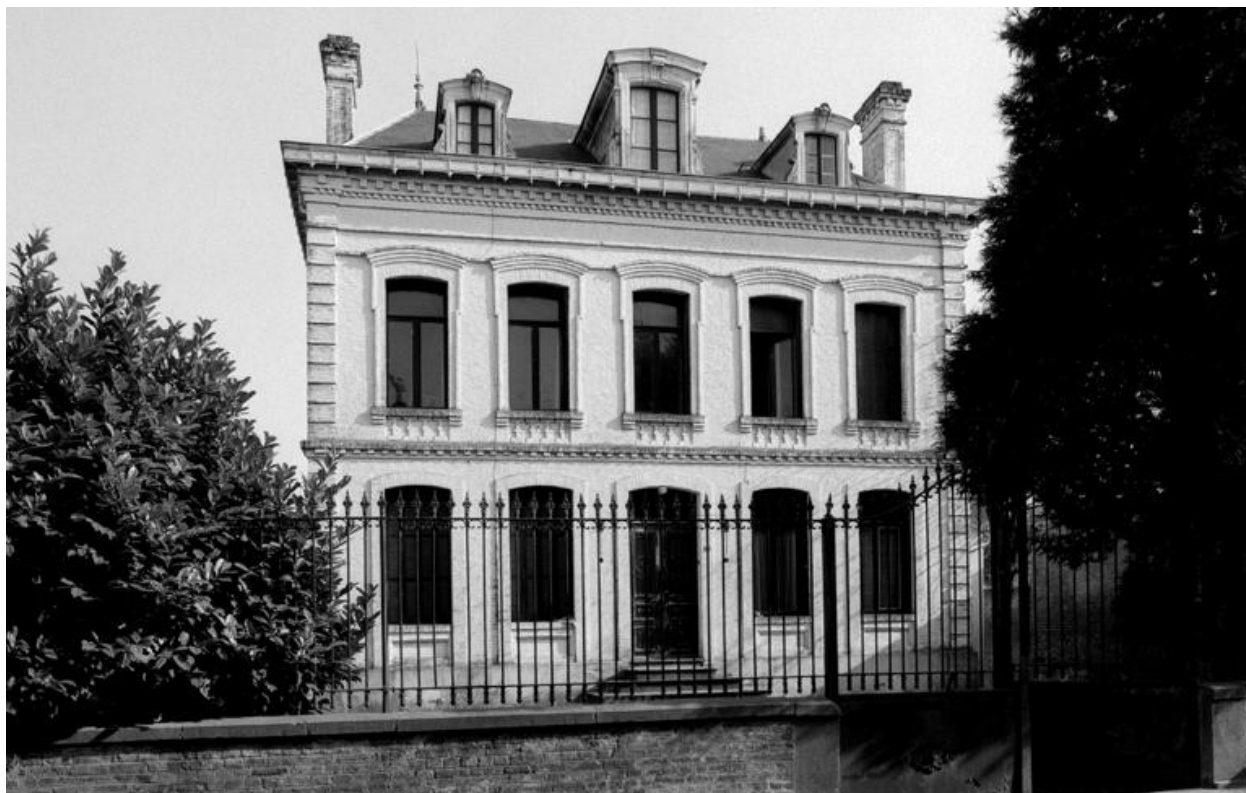
Vue d'ensemble de la façade.
