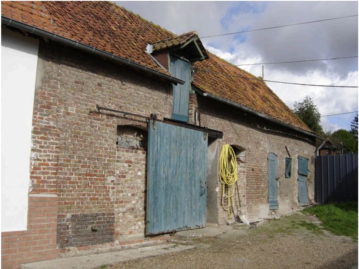
Vue des écuries au nord du logis, dans son prolongement.
