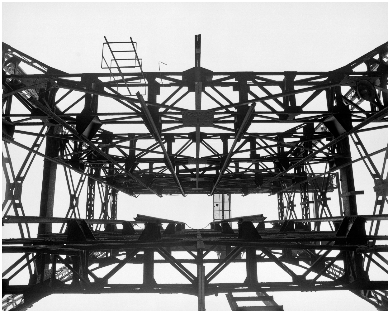
Portique assemblage : détail.
