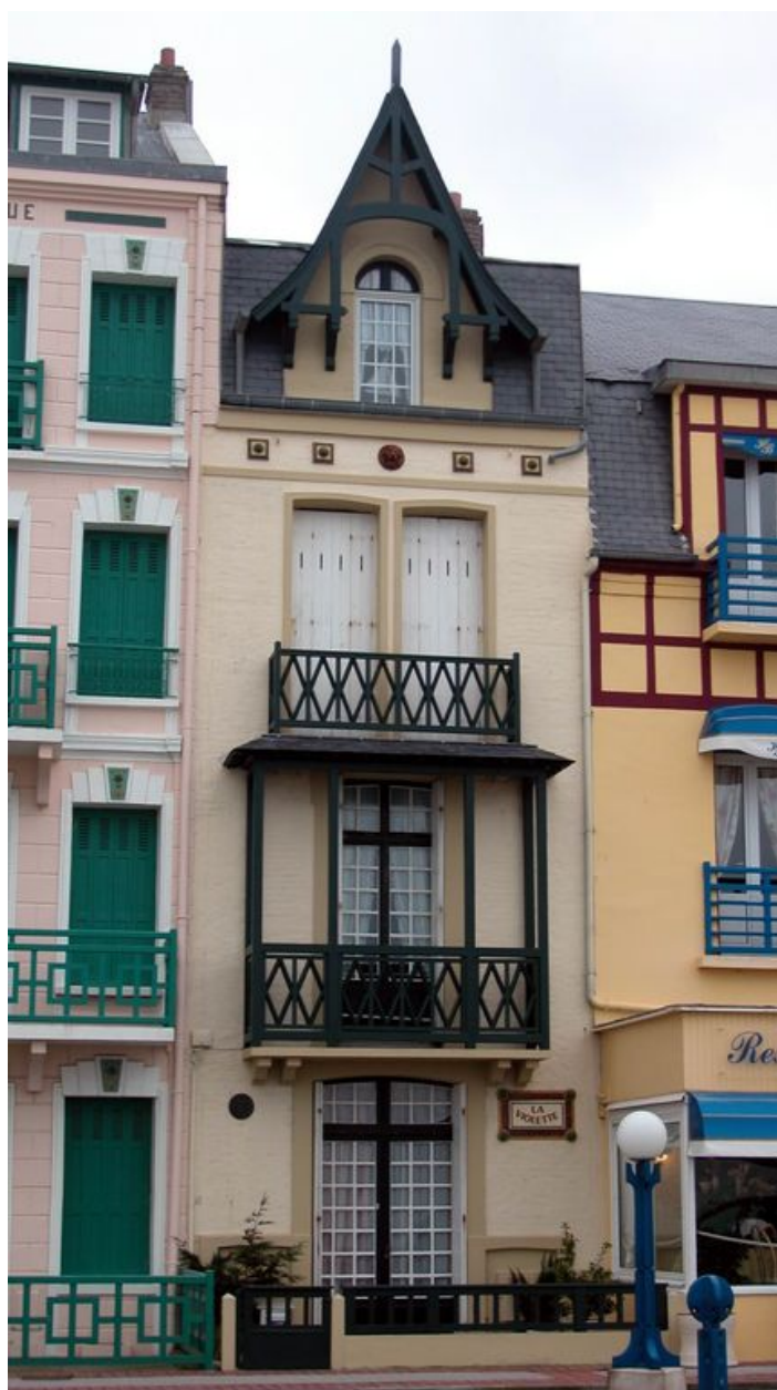
Vue d'ensemble depuis l'esplanade.
