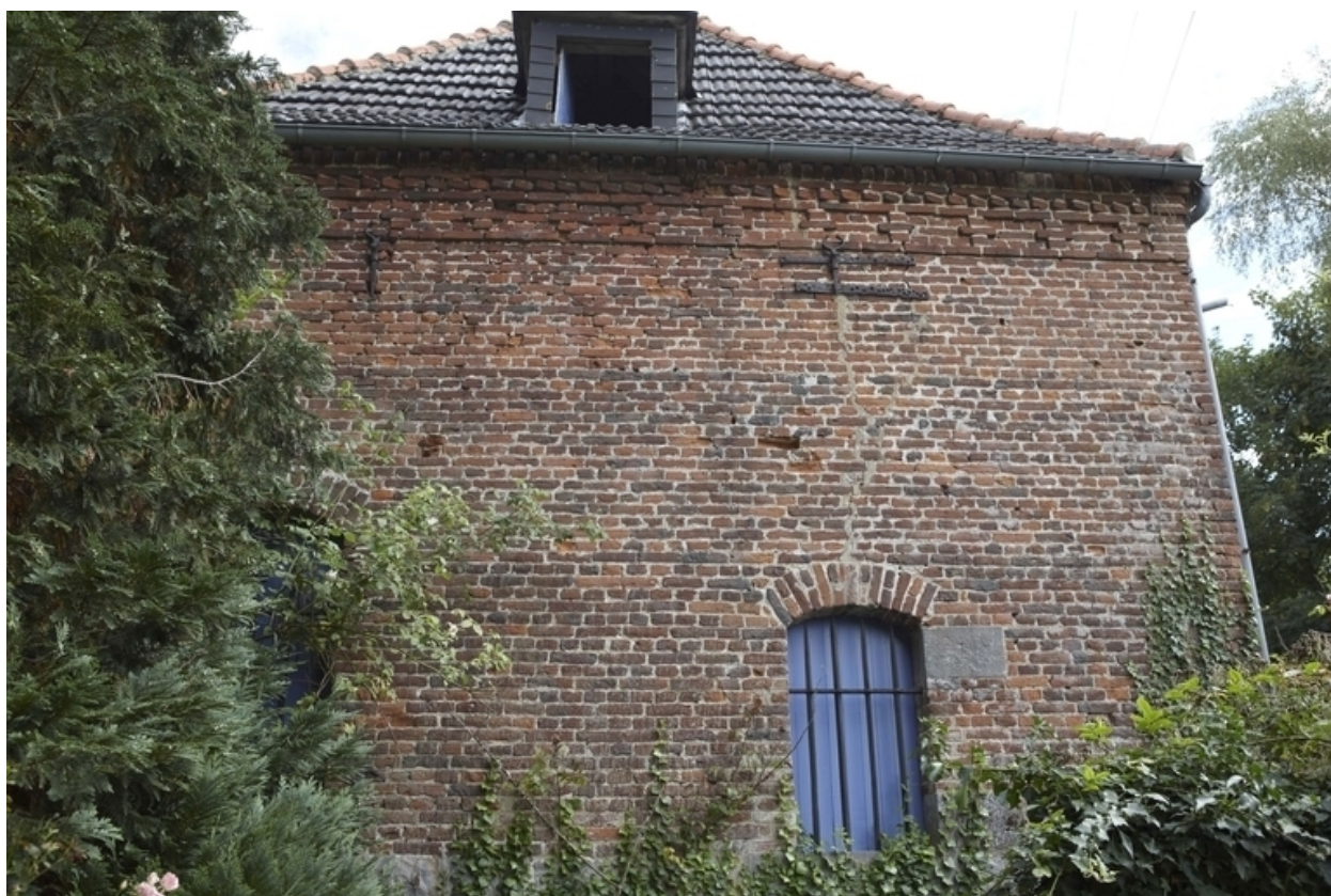
Détail du pignon sud.
