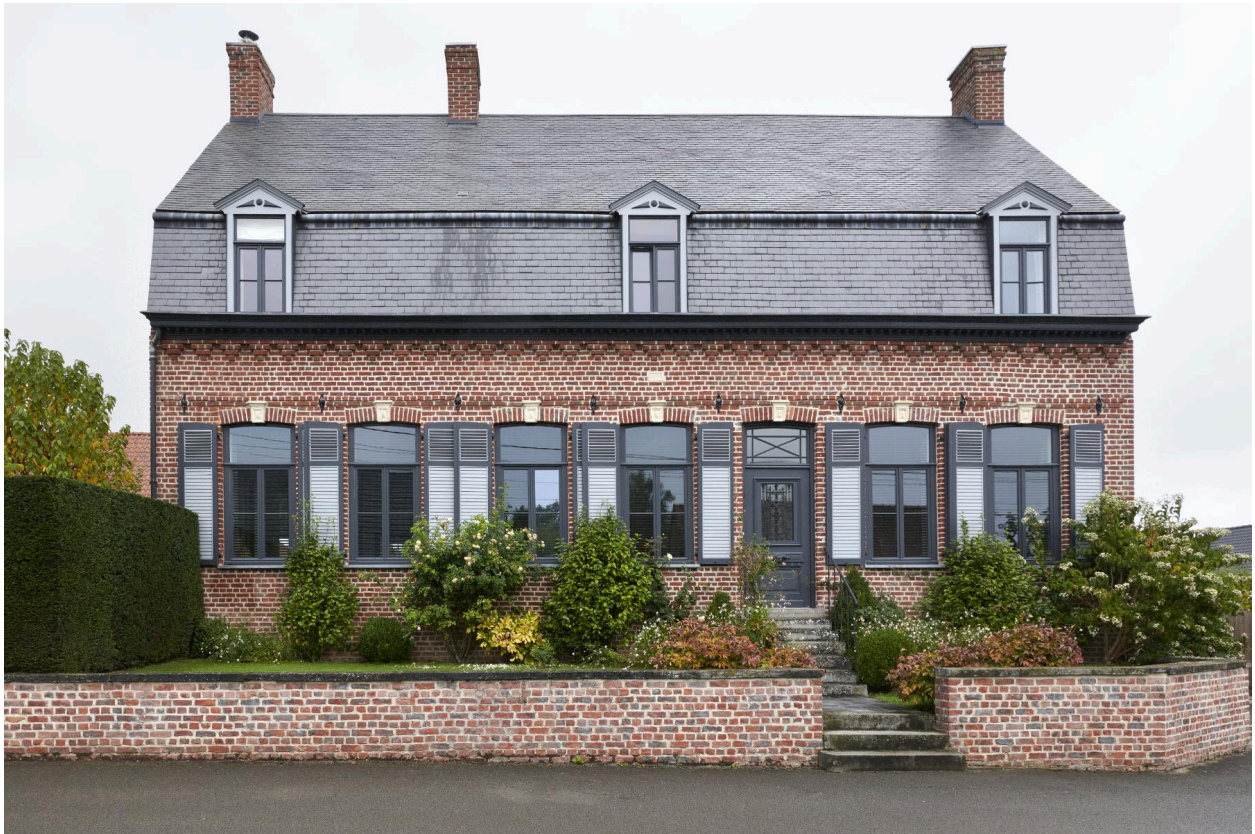
Façade principale sur rue.
