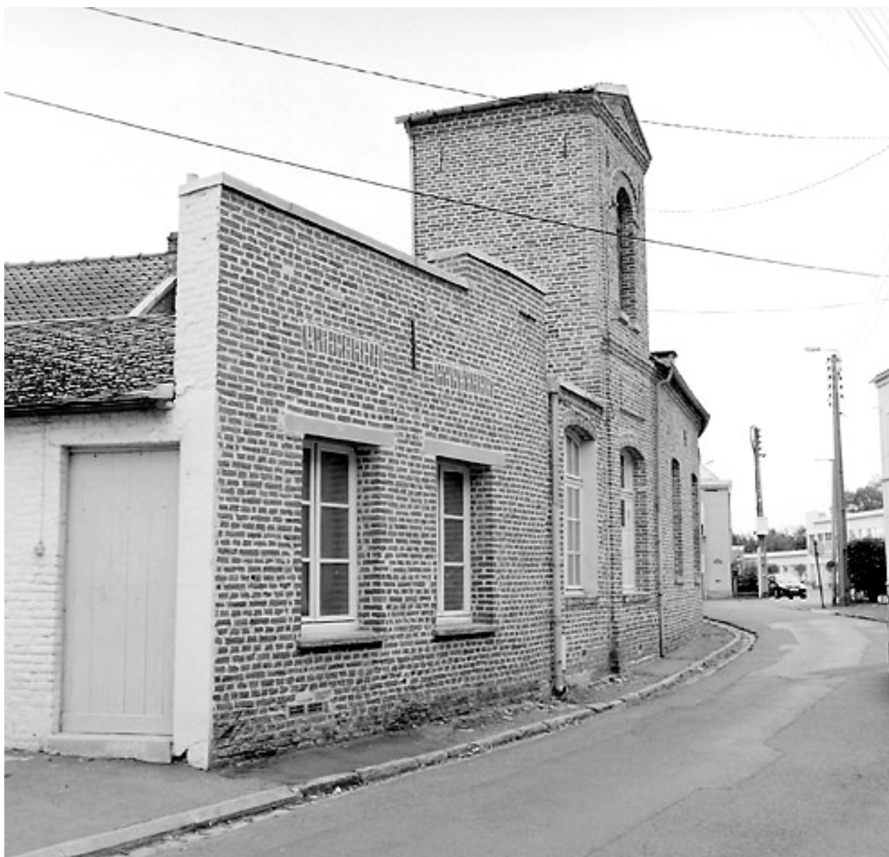
Rue Neuve, école des filles : vue depuis le nord-est, travée d'entrée surmontée d'un second niveau.
