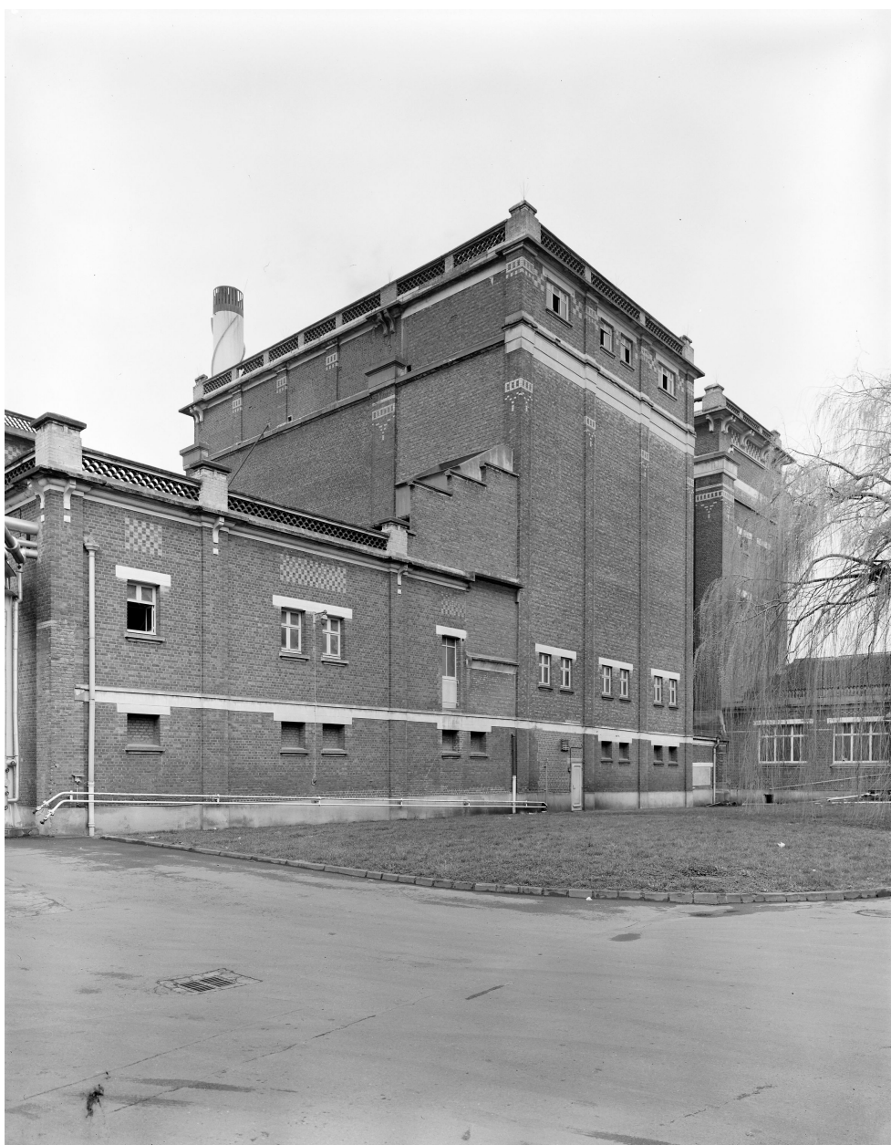
Malterie, élévation antérieure.
