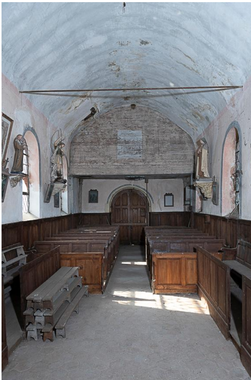
Vue générale vers la nef.
