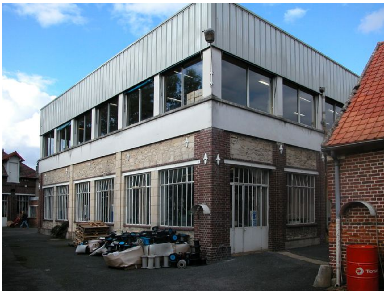
Façade postérieure de l'atelier de fabrication principal.
