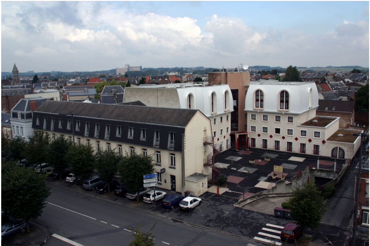
Le site de l'ancien tissage vu du sud-est.
