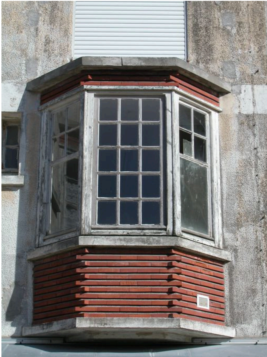
Détail d'un bow-window.
