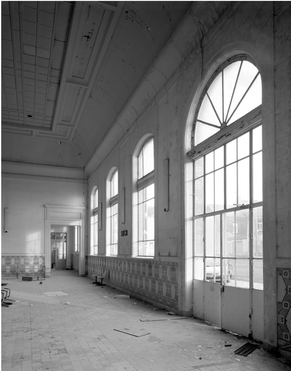
Entrée de la salle des pas perdus et couloir menant vers les bureaux de la douane.
