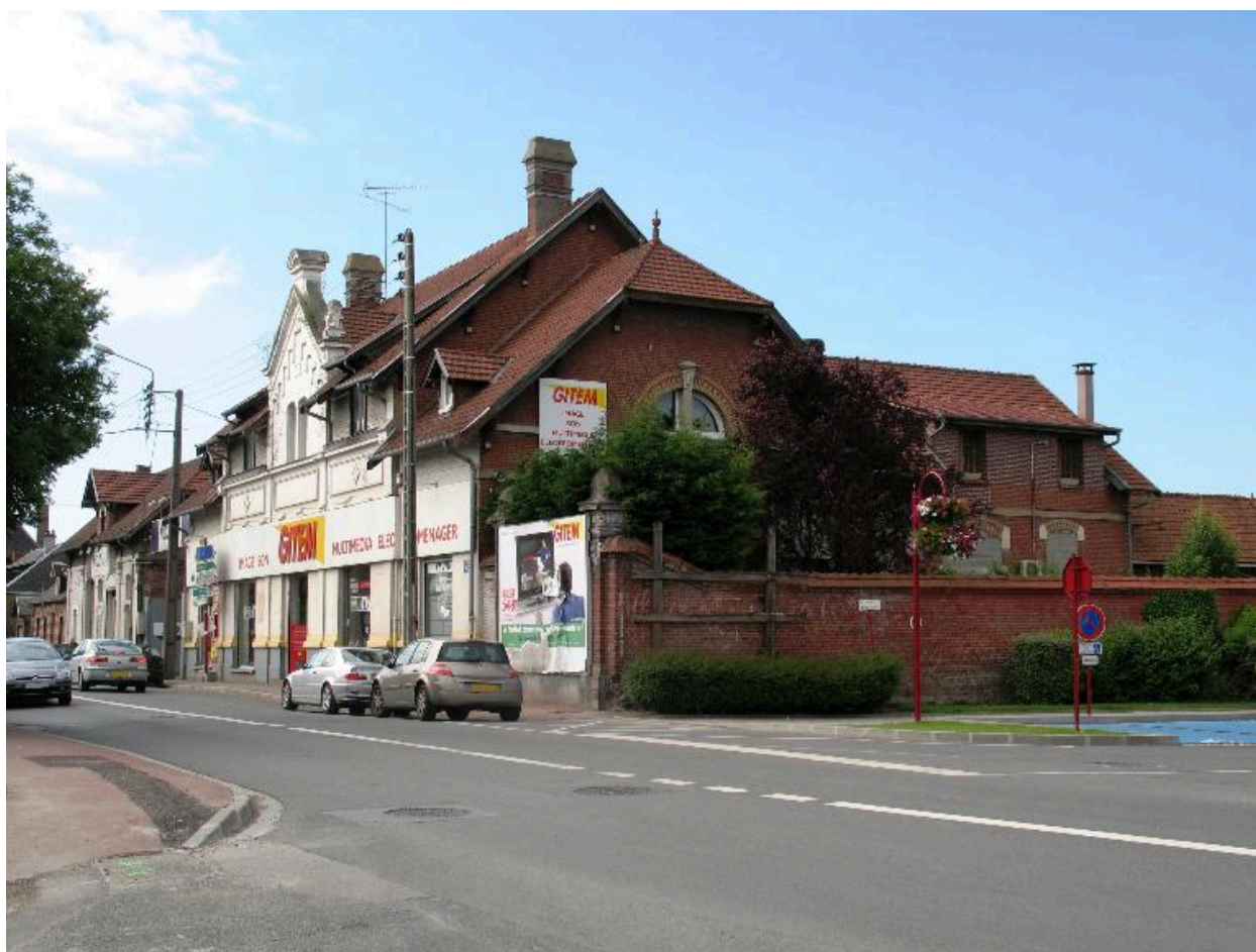
Vue d'ensemble, de trois-quarts sur rue.
