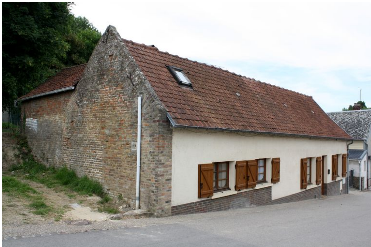
Maison, 10 rue du 8 mai 1945 (C 238)
