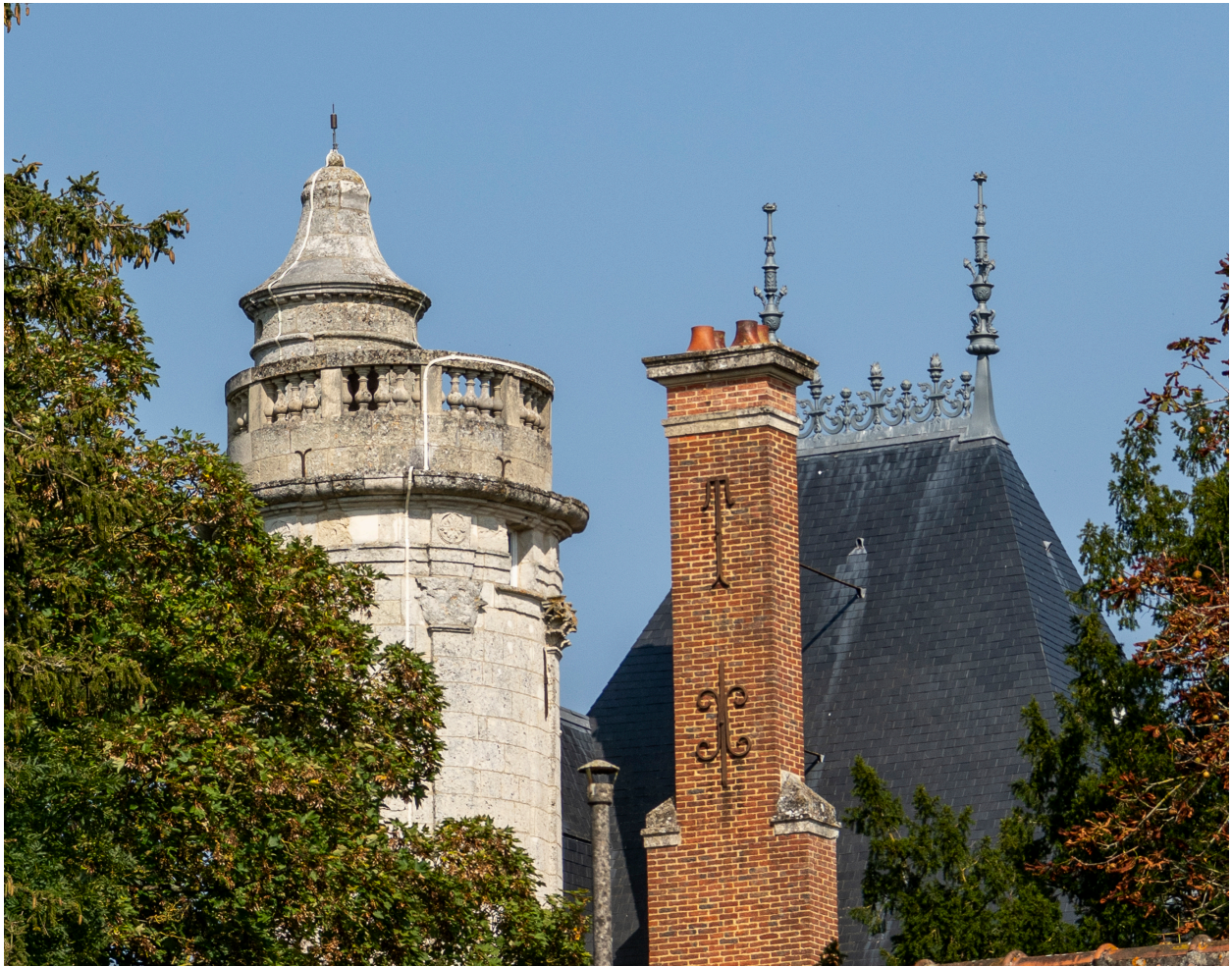
Sommet de la tourelle occidentale du château.
