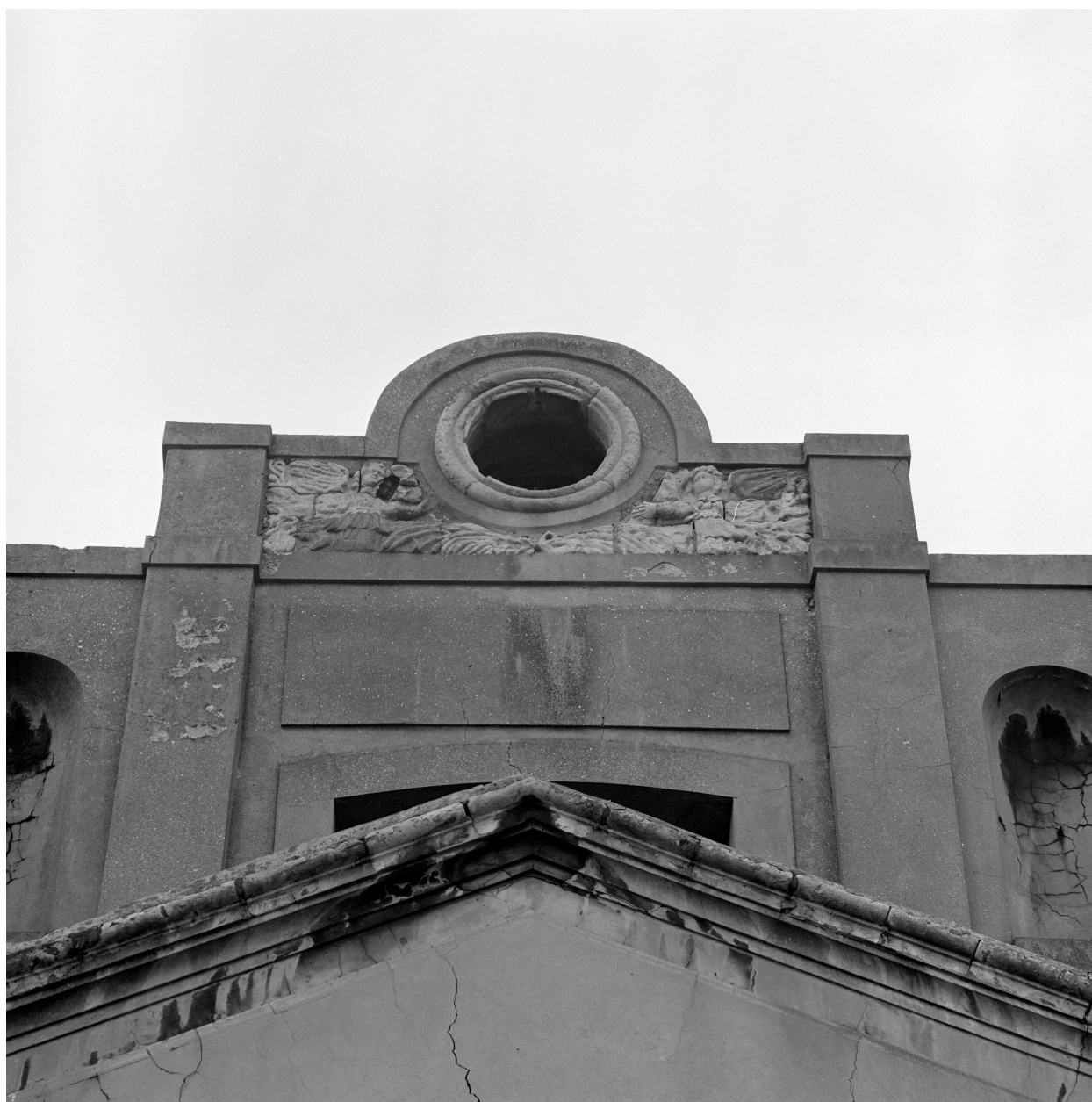
Chapelle, façade sur cour, oculus.
