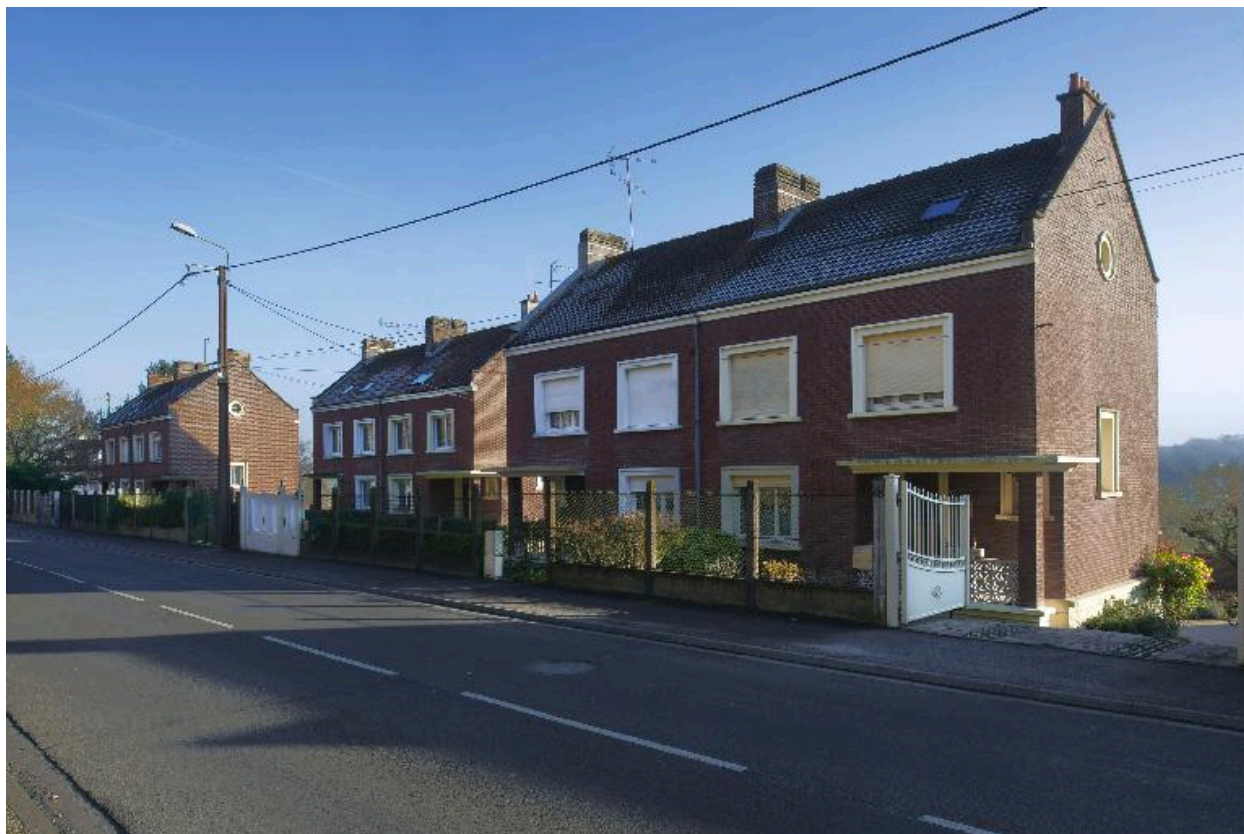
Vue des façades sur rue des logements.
