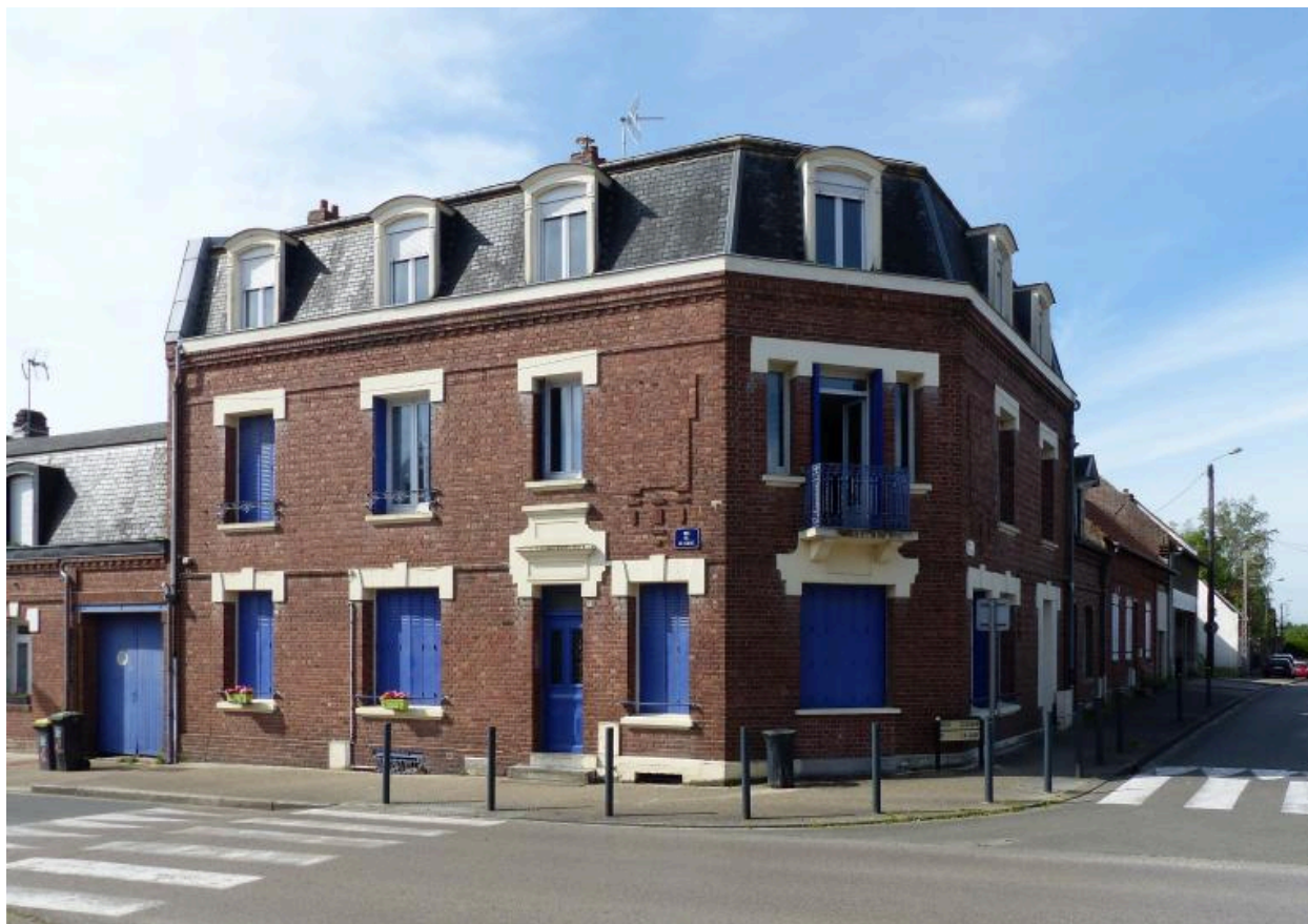
Maison, 2 rue de la Gare.
