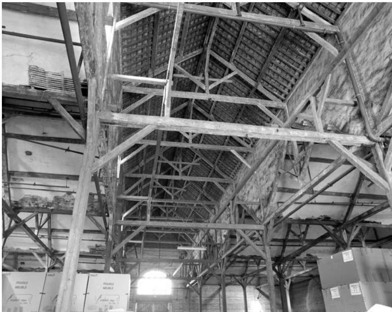
Magasin industriel, en 1989 : vue intérieure (charpente).
