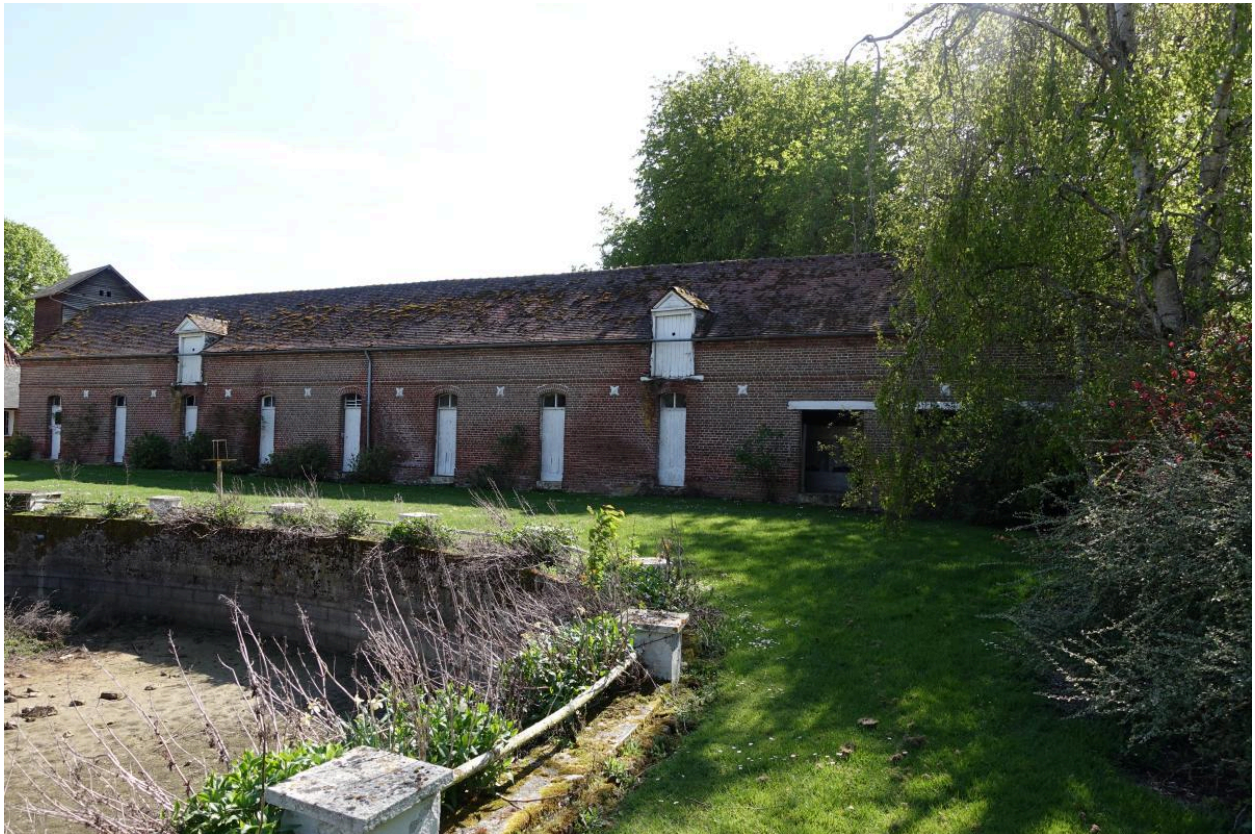
Anciennes porcheries, vue depuis le nord-est.
