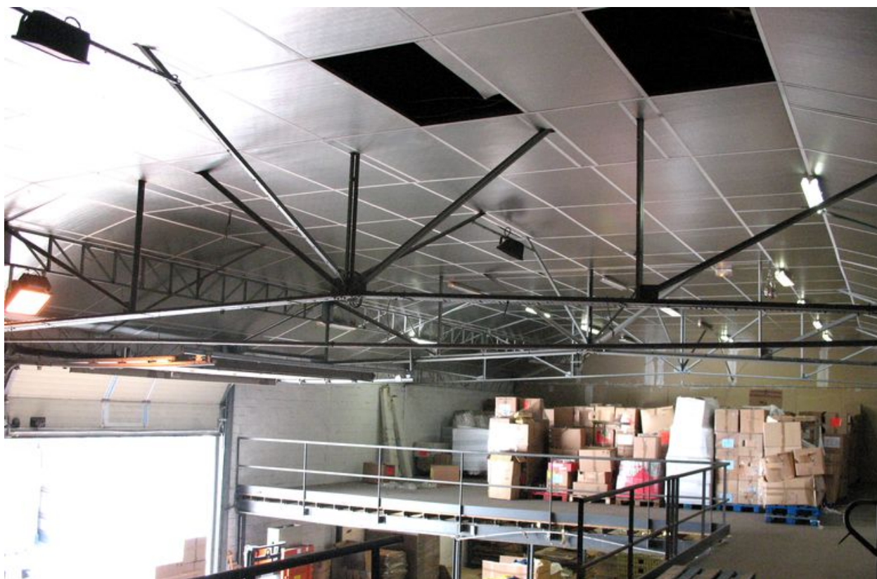
Charpente métallique de l'entrepôt.
