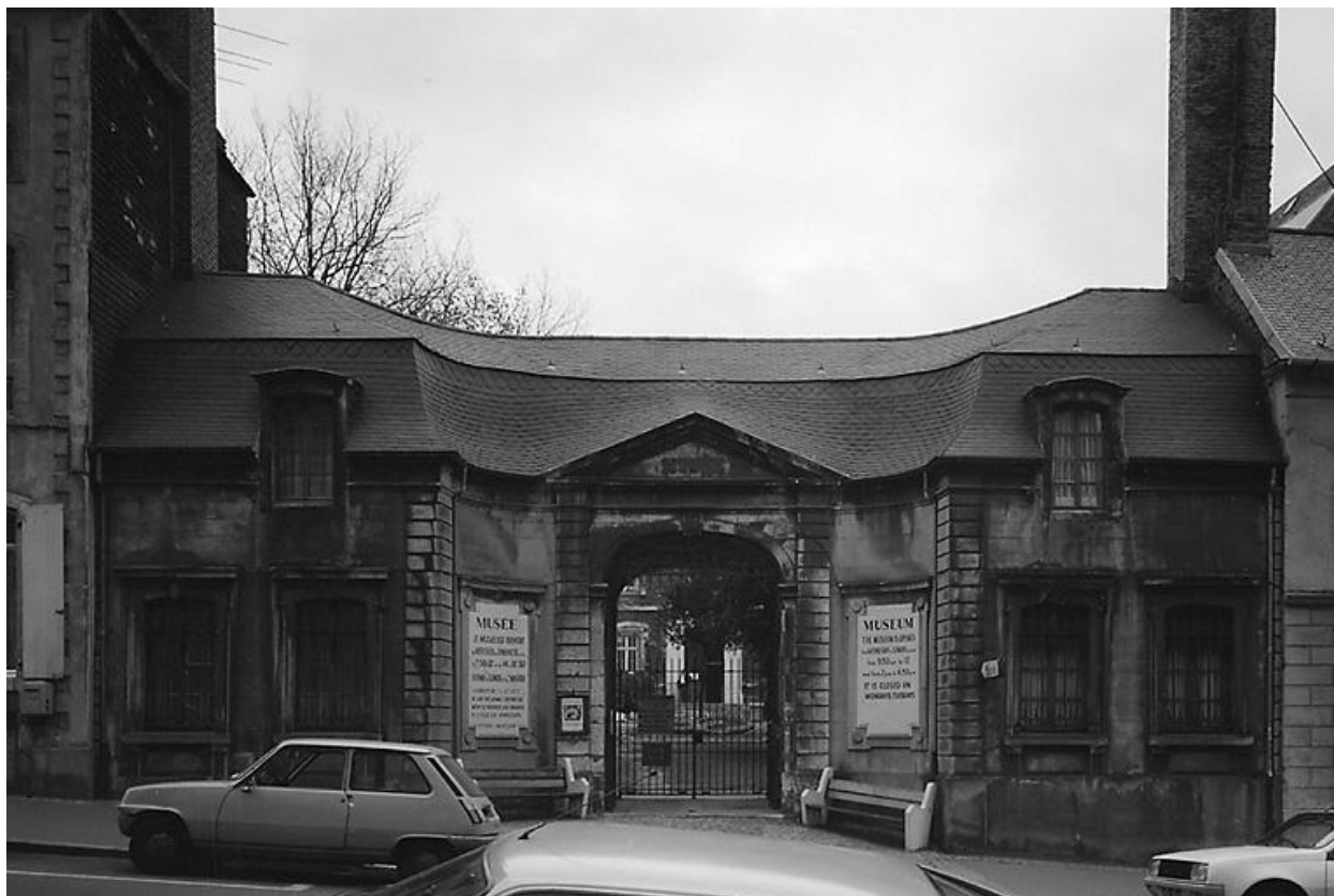
Corps de passage, façade sur voie.
