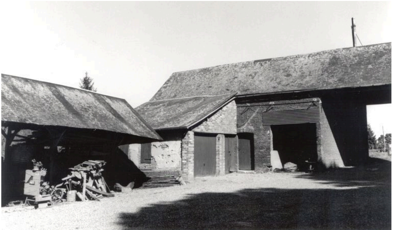
Vue d'ensemble sur cour des dépendances agricoles implantées au nord.
