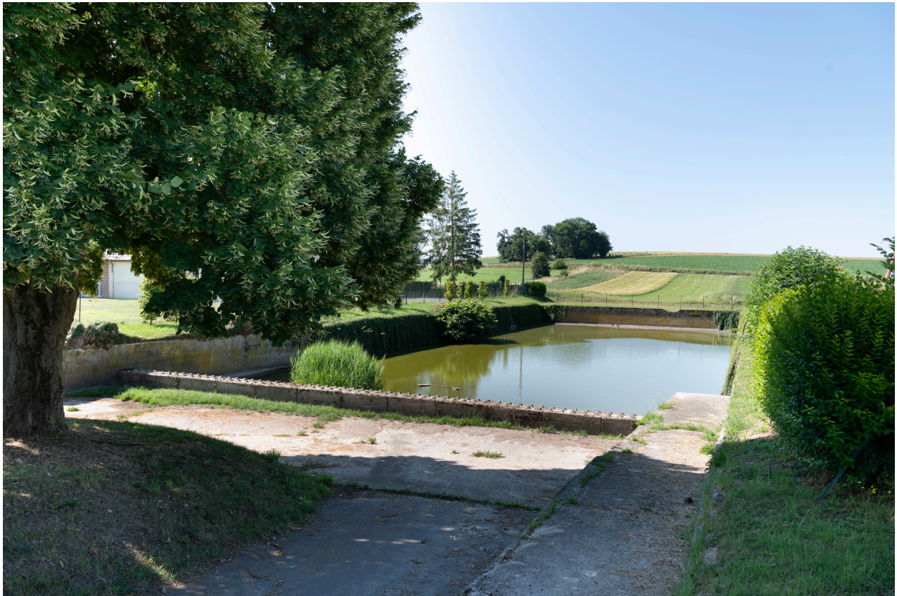
Mare de la rue Marcel-Dassault, vue depuis le nord.
