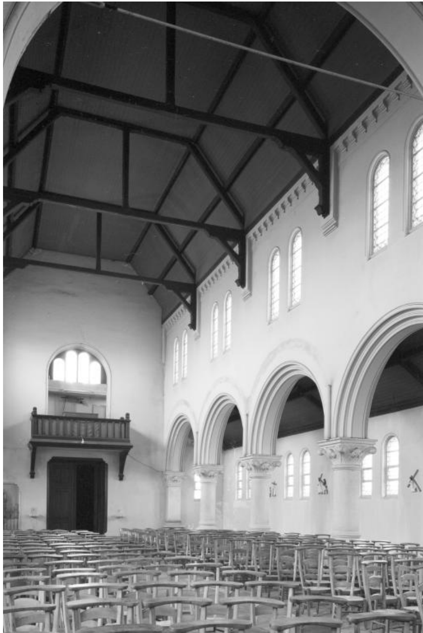
Vue intérieure, vers le nord-ouest.
