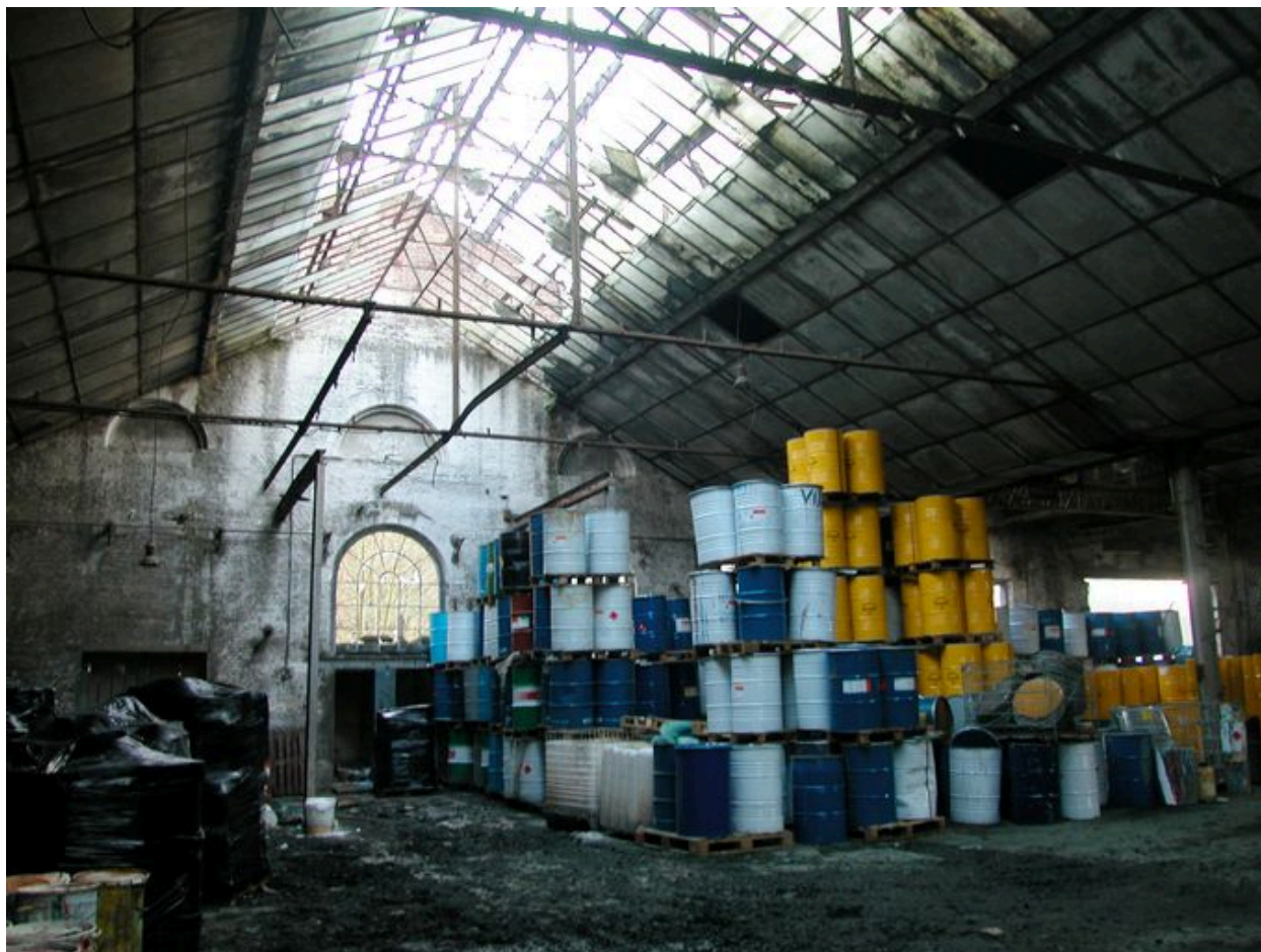
Vue intérieure de l'atelier de teinture.
