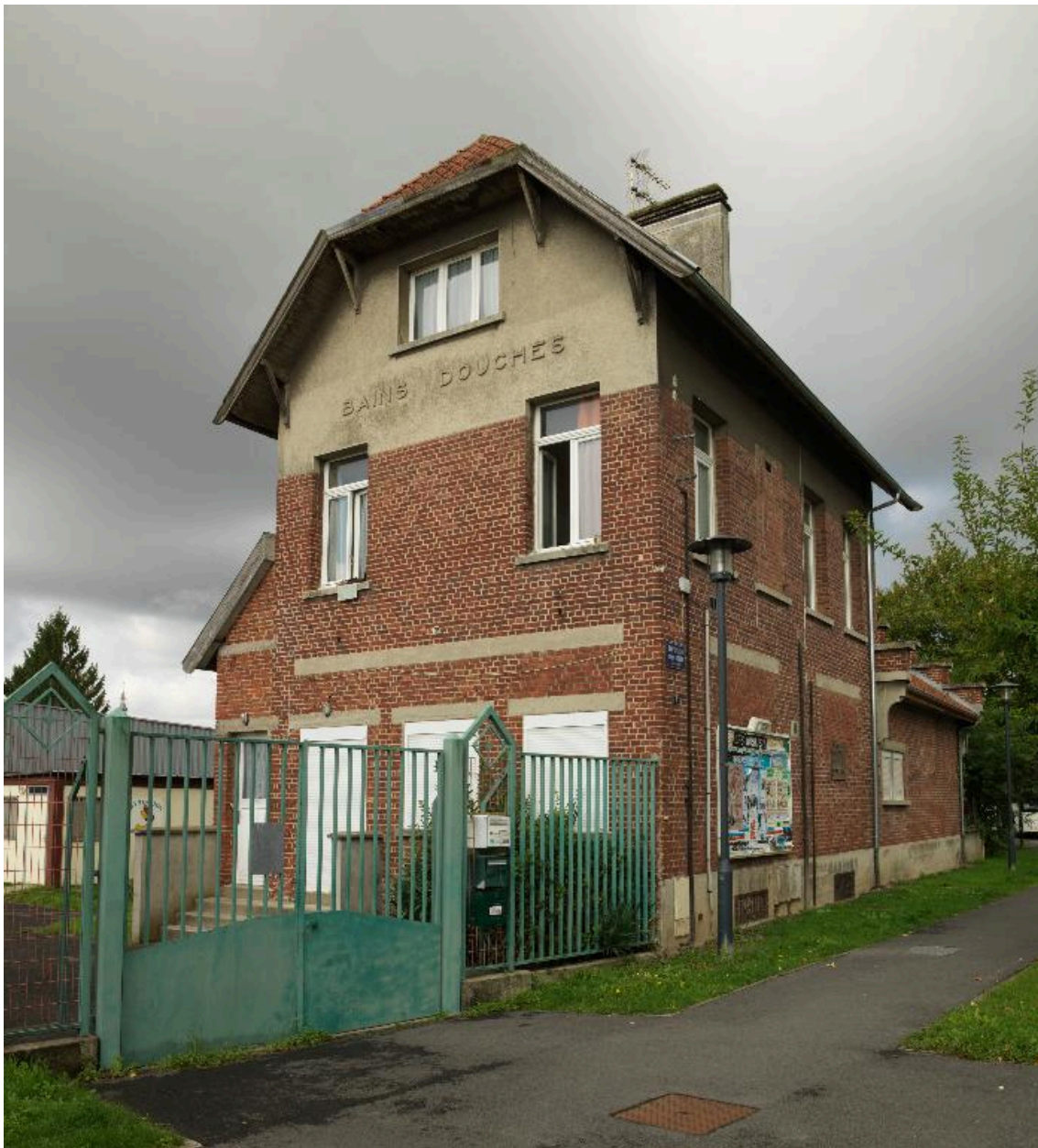
Bâtiment des bains-douches.
