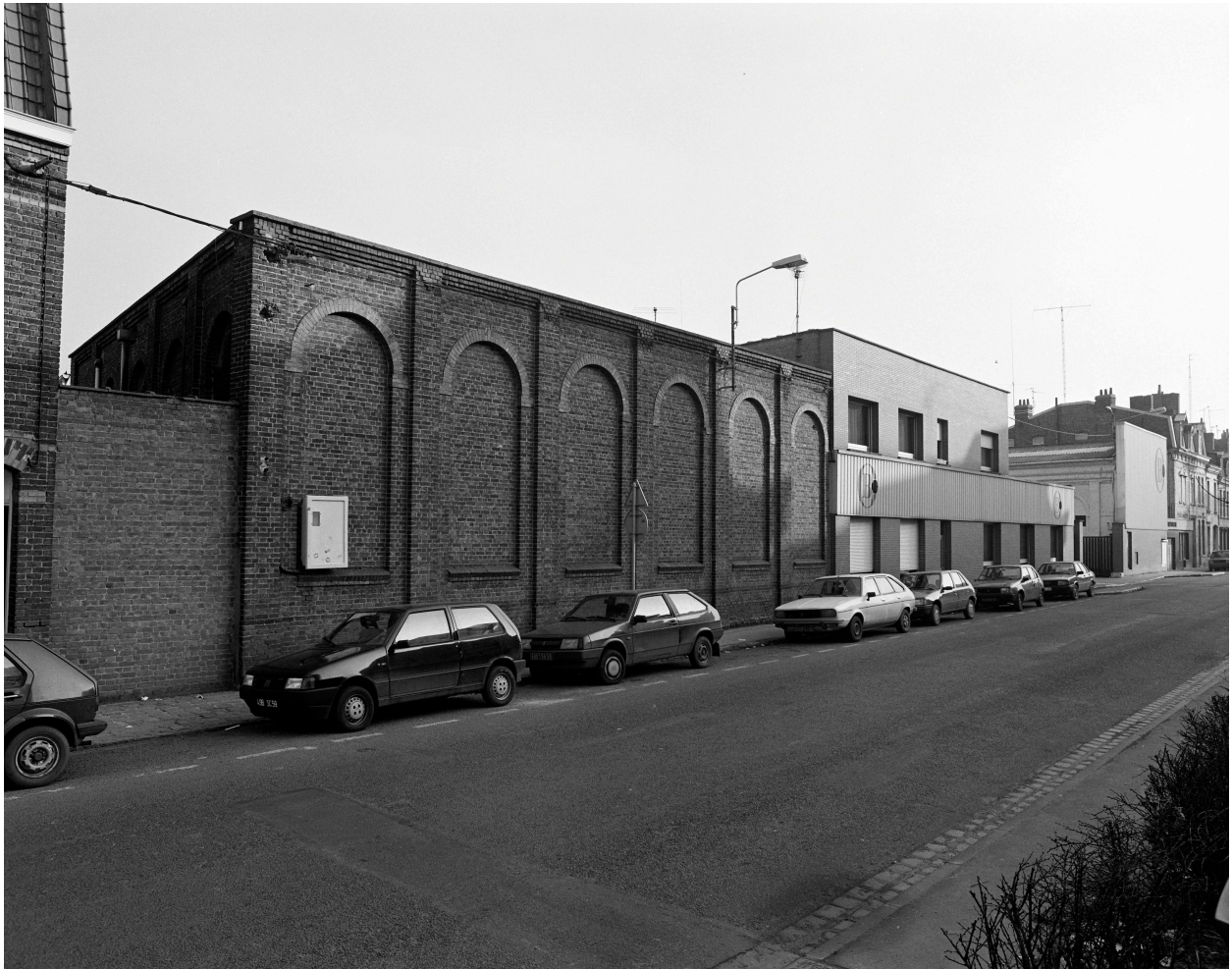
Élévation antérieure rue des Fusillés.
