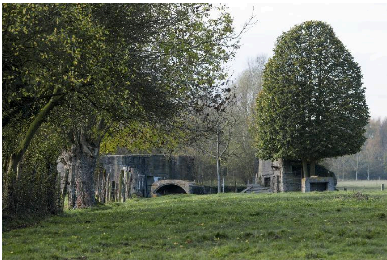
Illies, ensemble fortifié au lieu-dit Lannoy.
