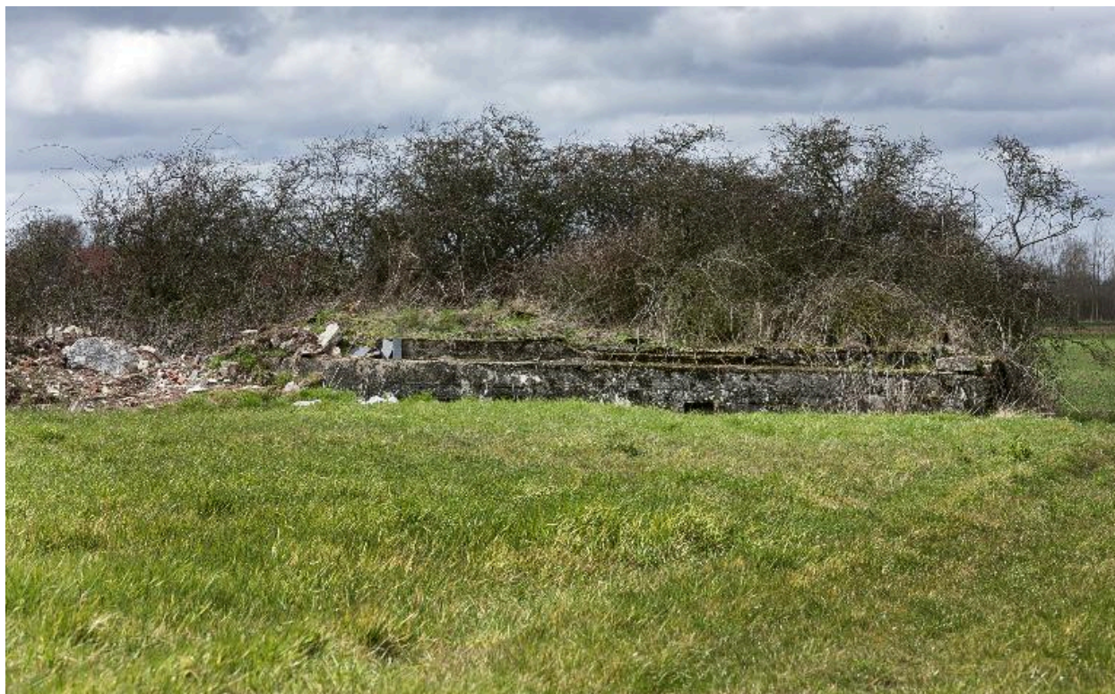
Elévation antérieure, vers l'ouest
