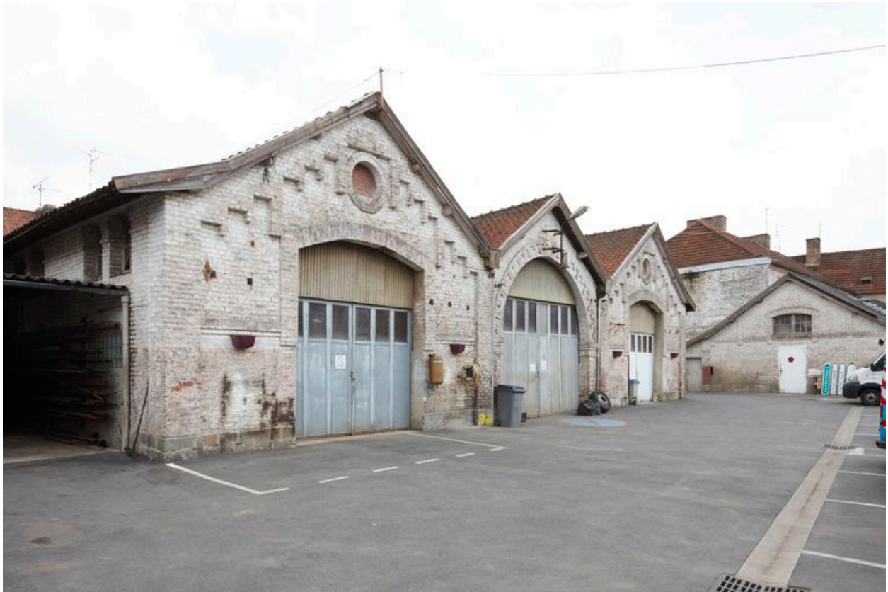
Cour, vue générale des tueries et de l'atelier de dépeçage. Au fond, l'étable à cochons.
