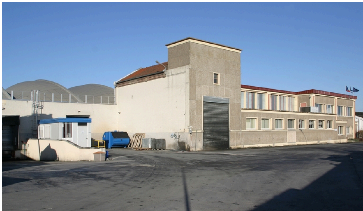
Façade de l'usine côté cour : de gauche à droite les ateliers, l'ancienne salle des machines (masquée en façade), les bureaux.
