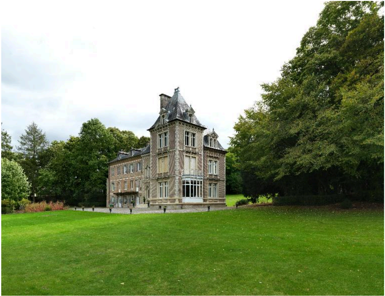
Vue d'ensemble nord-ouest du château.
