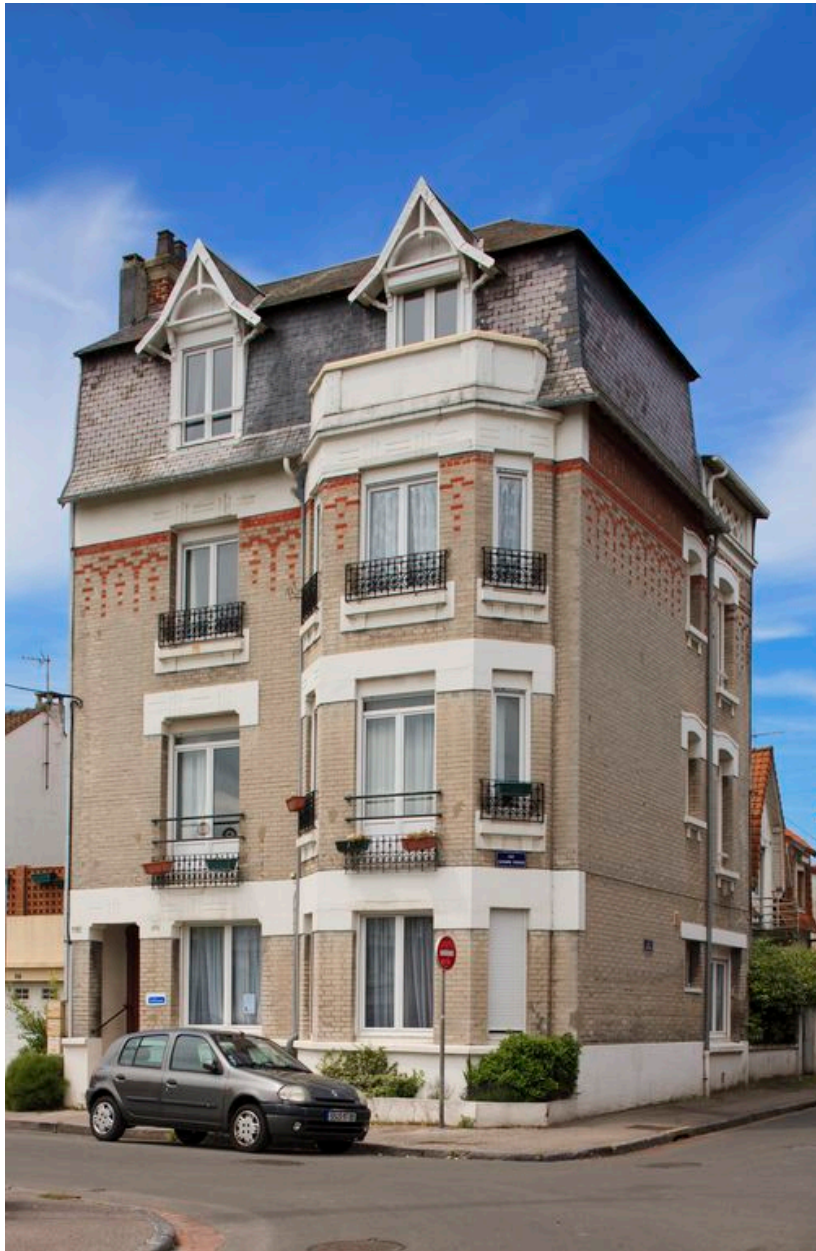
Vue générale de l'immeuble.
