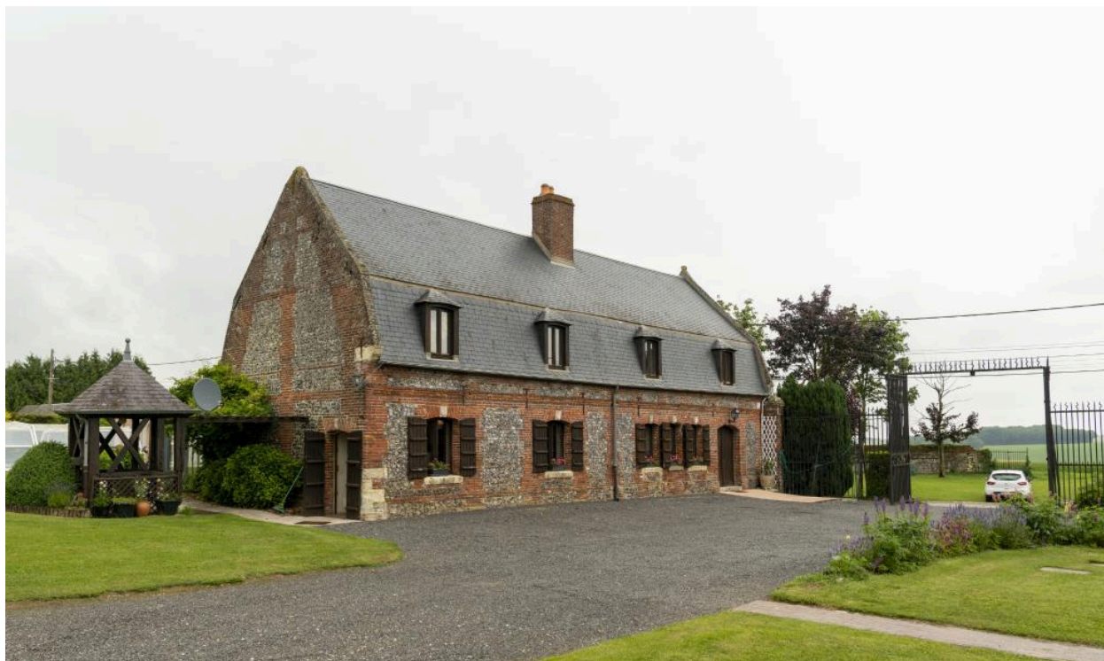
Vue générale du logis et du portail d'entrée.
