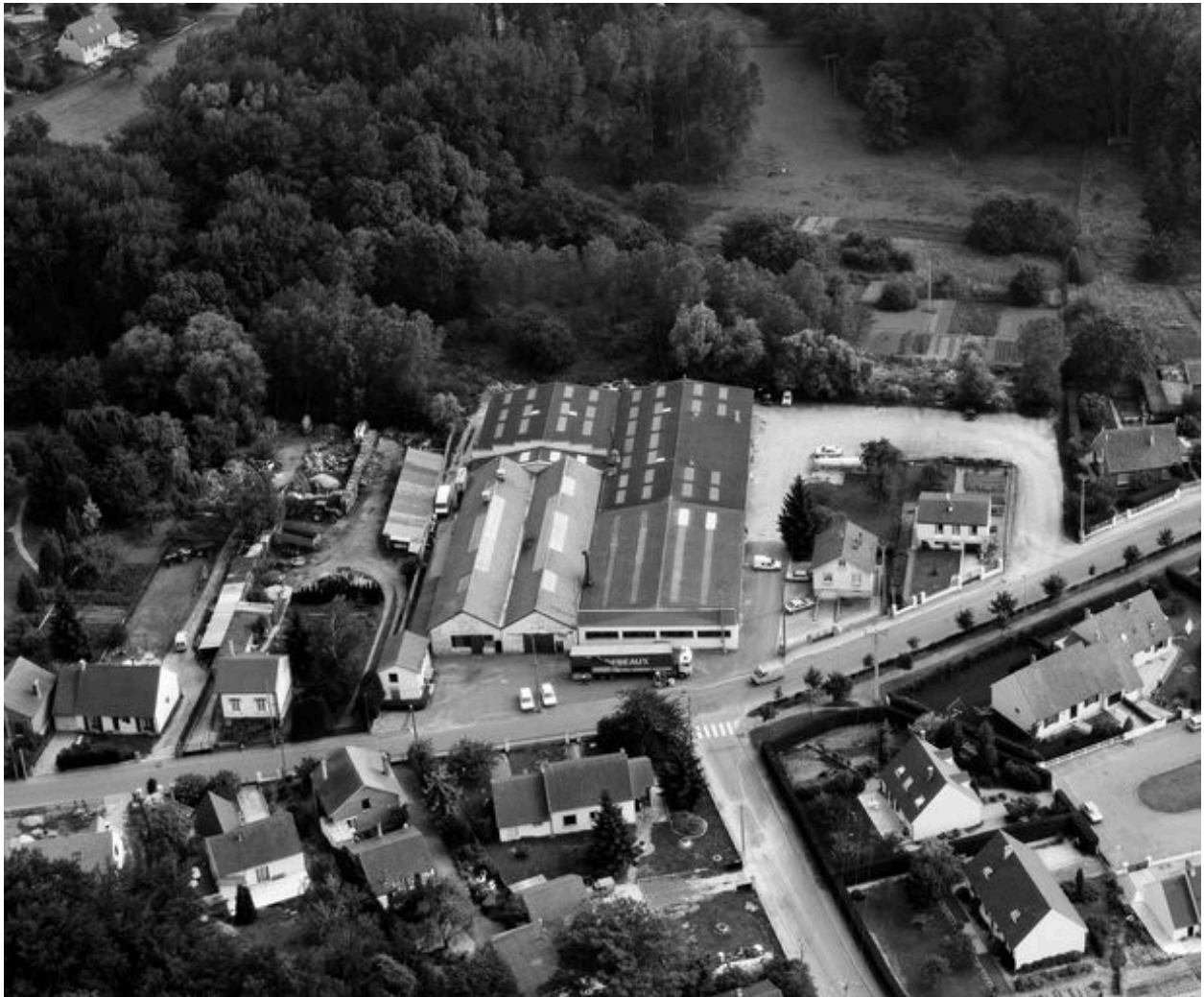
Vue aérienne de l'usine, en 1991.
