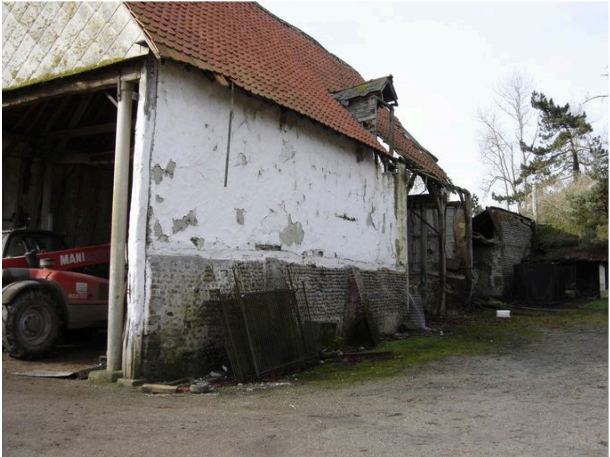
Vue du côté nord de la grange.
