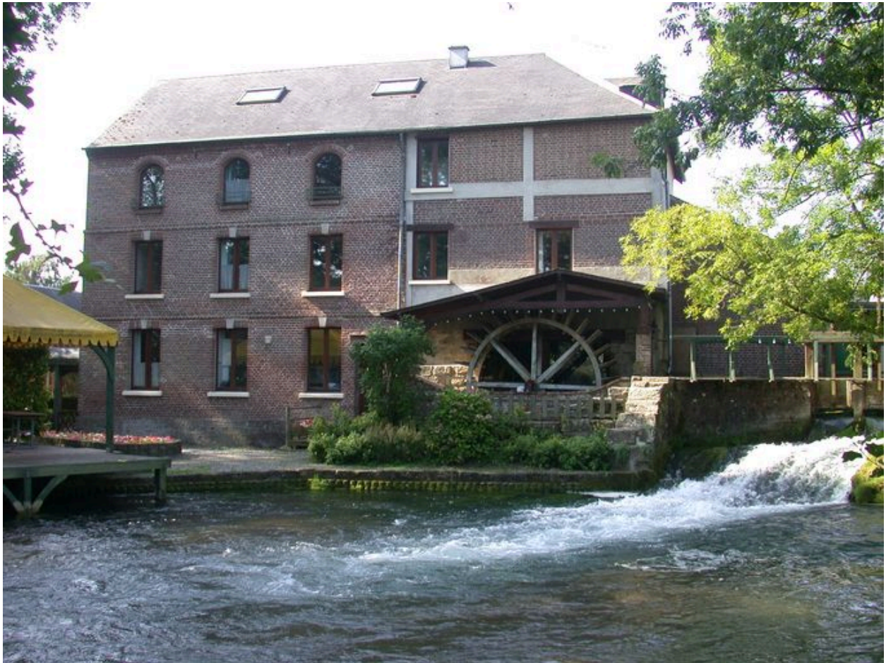
Vue d'ensemble postérieure de la minoterie.
