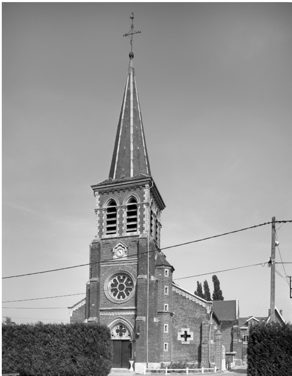
Vue d'ensemble de la façade.
